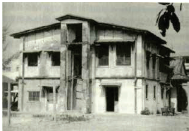
圖四 台灣首先裝置手搖升降機的新樓醫院。
